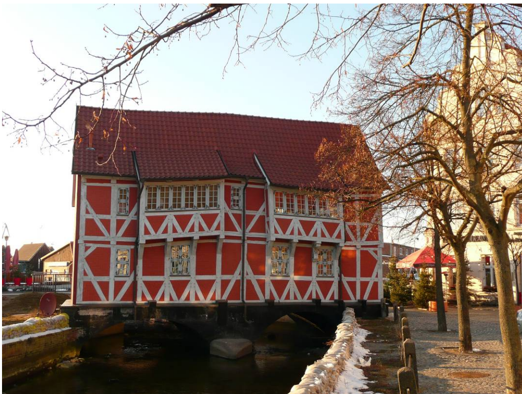
Schiefes Gewölbe, Wismar
