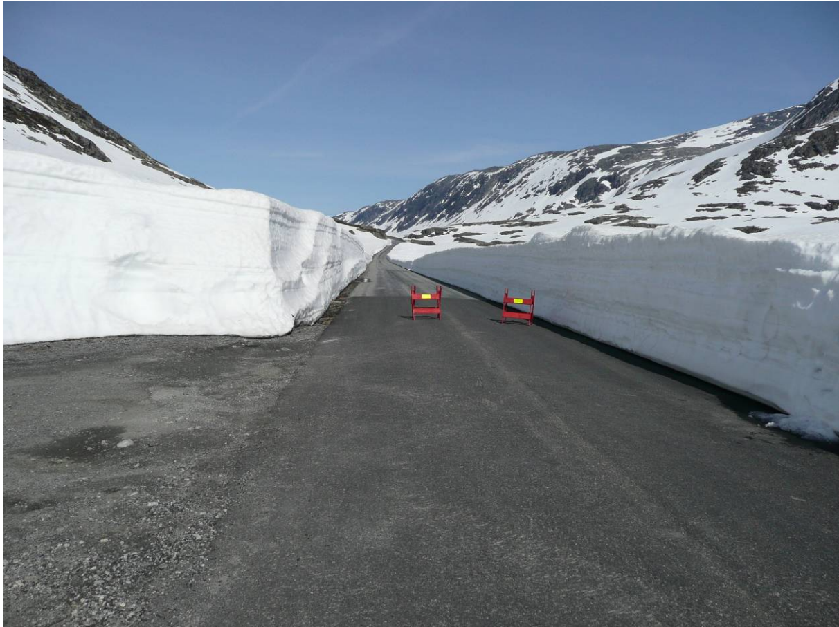
Straßensperrung am alten Strynfjelletvegen
